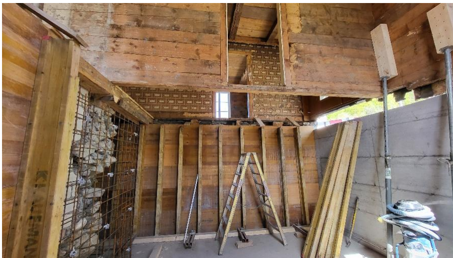
neue Aussenwand betoniert im UG-Bereich
