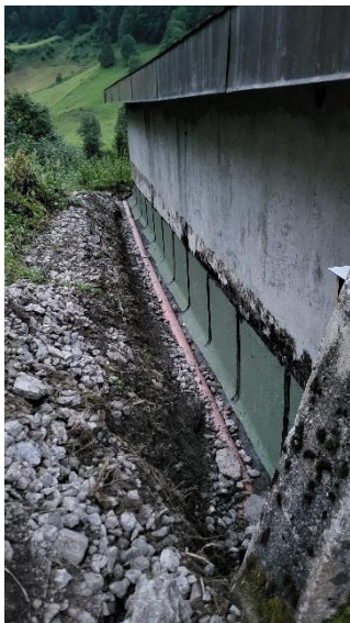
neue Abdichtung an Aussenwand
