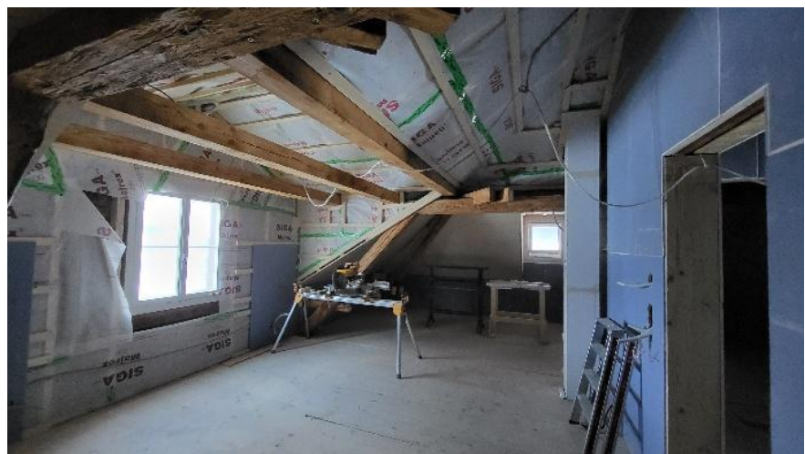
neuer Dachstockausbau, Zimmer mit Gaube
