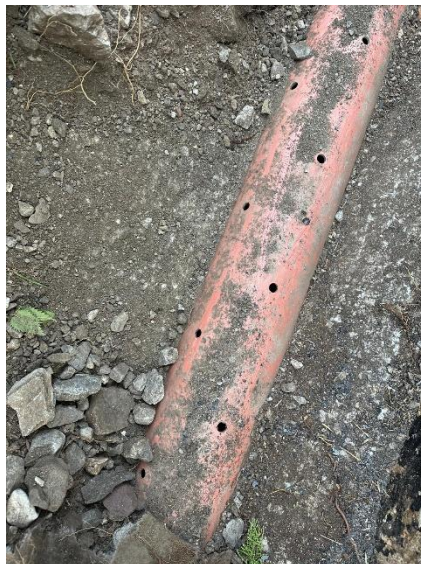
freigelegte Sickerleitung
