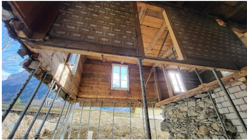
Aussenwand der Südwestseite auf provisorischen Deckenstützen
