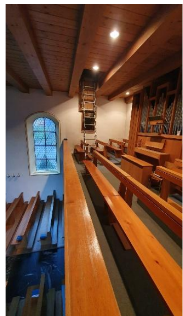
Empore mit Zugtreppe auf Dachstock
